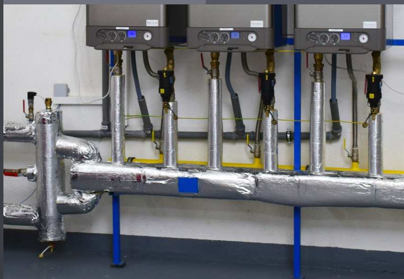
Reálná instalace včetně zaizolování
